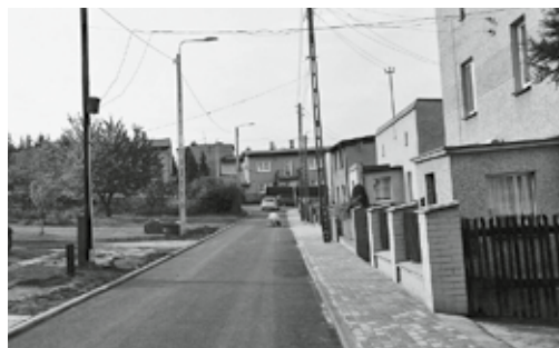
ul. Gałczyńskiego po remoncie.
